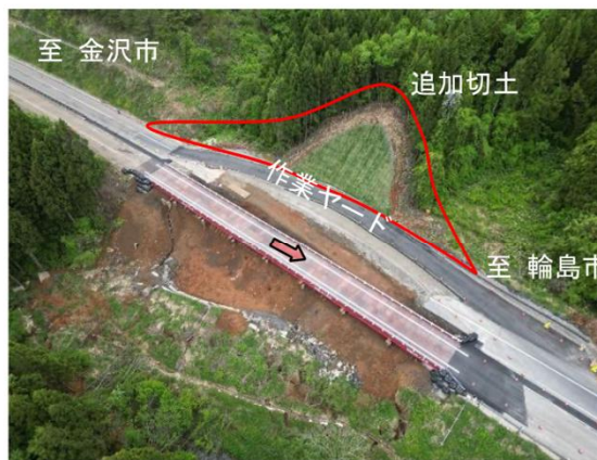
仮橋設置 (R6.5月：追加切土のための仮橋設置完了)
