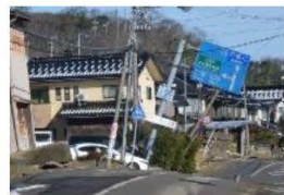
内灘町西荒屋地内（液状化）
