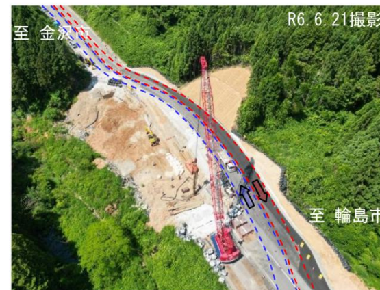
2車線確保 (R6.7.17：対面通行確保予定)
