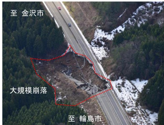
被災直後 (14.1kp大規模崩壊)
