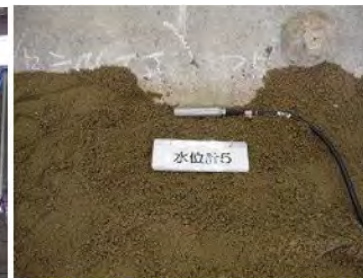
写真-22 水位計5(WL05)の設置
