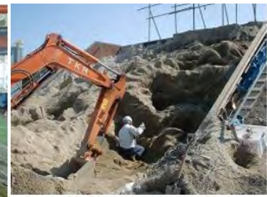
写真-41 撤去作業②
