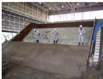
写真-18 足踏み転圧
