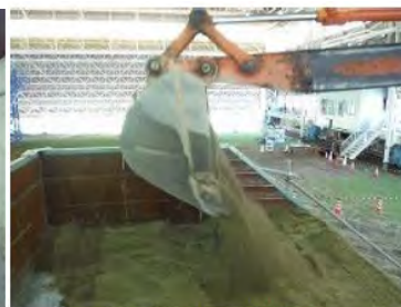
写真-33 土砂搬入
