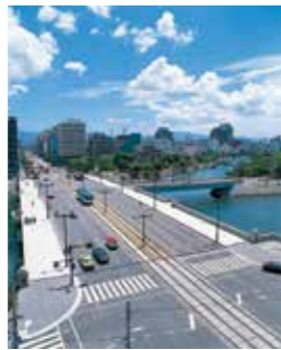
▲相生橋架替完成
