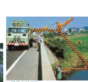
▲橋梁点検業務
