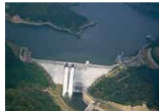
▲八田原ダム完成
