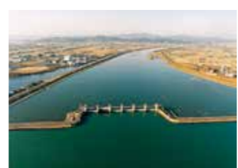
▲百間川河口水門
