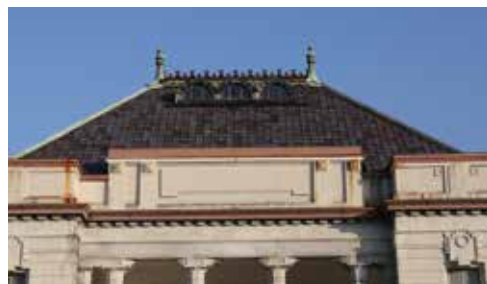
中央部の屋根に施されている半円形の飾り窓、その後部の突起物の装飾は、庁舎正面のアクセントになっている。
