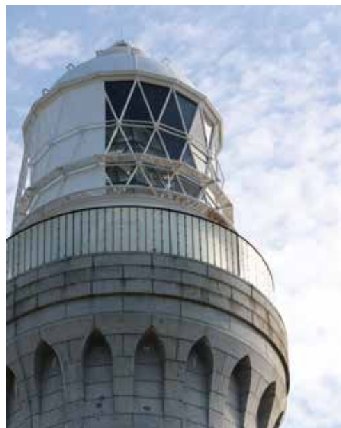
角島灯台の灯塔は円筒形で、外周にはテラスが周り、鉄製の縦格子の手摺がつく。正八角形の英国製フレネルレンズを使用
