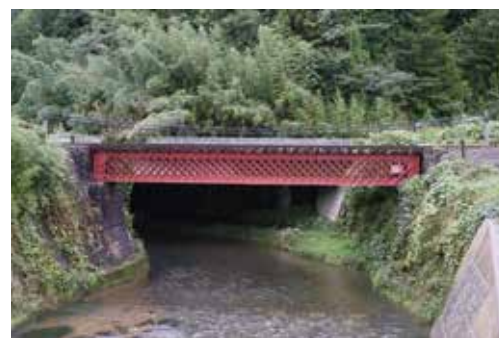
阿武川支川沖田川に架かる徳佐川橋梁。平成 25 年 7 月 28 日山口・島根豪雨災害にも耐えた。
