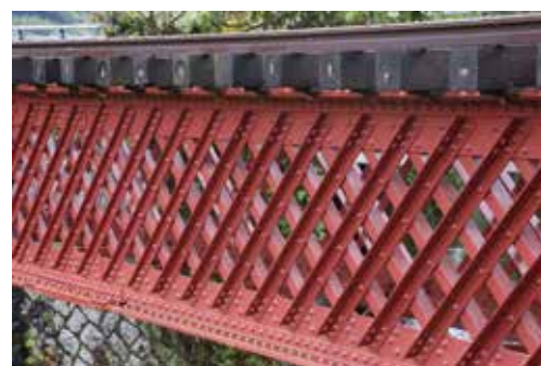
規則正しく並ぶ山形鋼の断面が L 字型の鉄材を直角に交わるように格子状に組み立てられている
