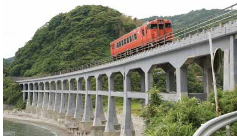
選奨土木遺産「惣郷川橋梁」 波打ち際に美しい曲線を描く、景観に優れた鉄道用の R C ラーメン橋
