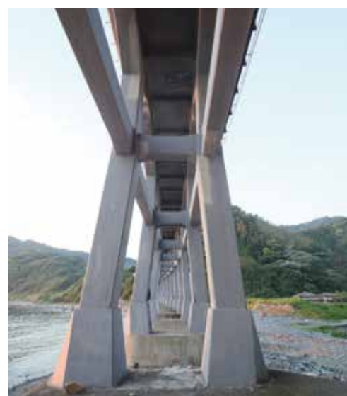
惣郷川橋梁 開脚式の橋脚が安定感を与えている
