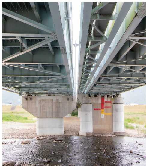
新旧の新橋の橋脚
