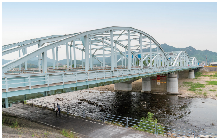
新旧のアーチ橋が並ぶ新橋（佐波川上流から）旧：L=156m, b=8m 新：L=156m, b=9.5+3m
