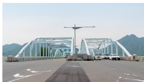
新旧の2橋が並ぶ新橋（佐波川左岸側から）
