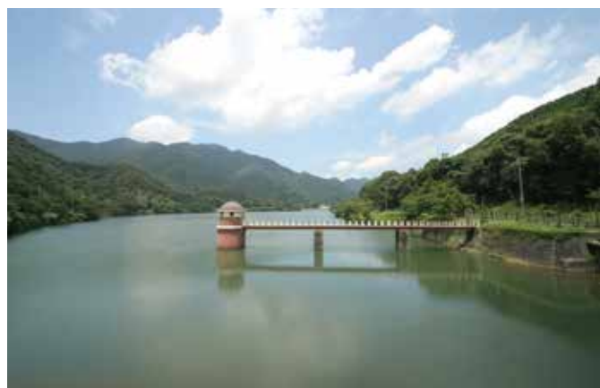
内日第1貯水池と取水塔
