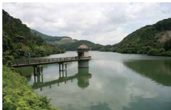
内日第2貯水池と取水塔
