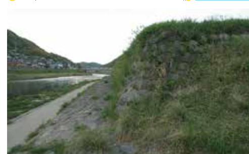
木野の渡し場の名残である巻石護岸の西側に舟つきスロープが残っている
