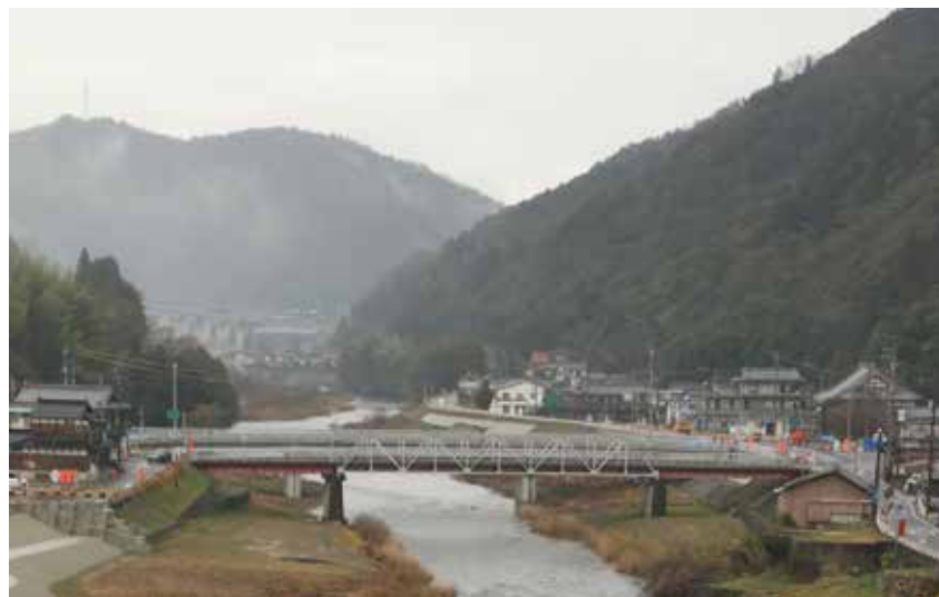
両国橋と新たに上流に架設された新両国橋
