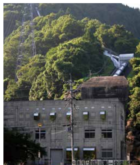
錦川第一発電所（大正13年）周南市金峰
