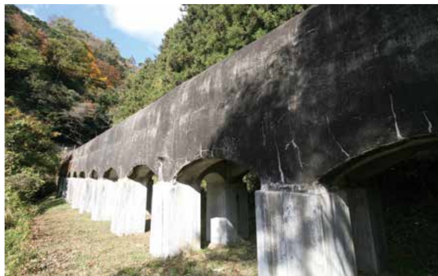
第2水路橋（大正13年）
