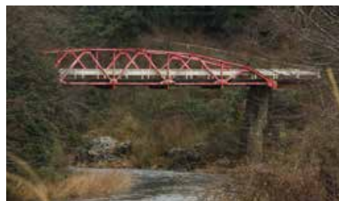
建設された位置で現存する鋼単純トラス橋では日本で2番目に古い
