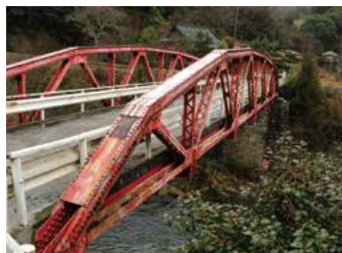
松室大橋 下路単線曲弦ワーレントラス (橋長41.5m 幅員4.1m)
