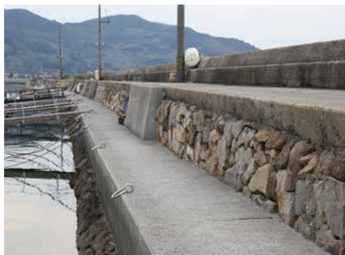
明治13年完成後、改築工事を重ねて現在に至る久賀の新波止。内側に船繋ぎを持つ子持ち波止の空築ぎが特徴。
