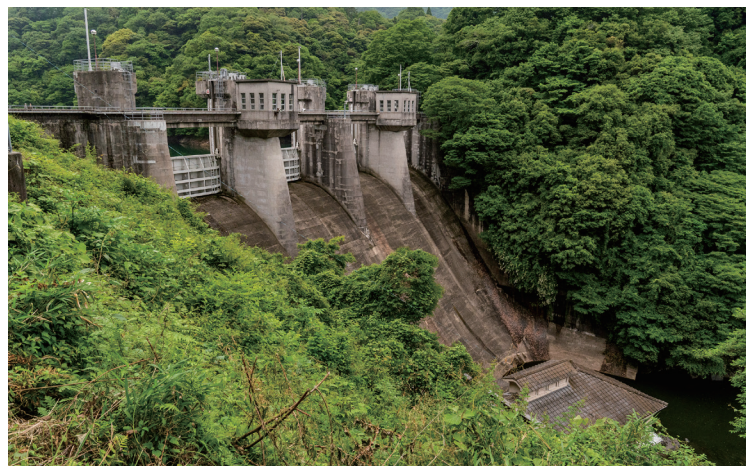
扶壁の上にゲート操作室が乗る「向道ダム」
