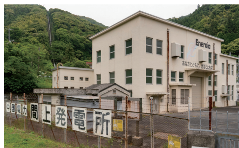
向道発電所から水が送られる間上発電所
