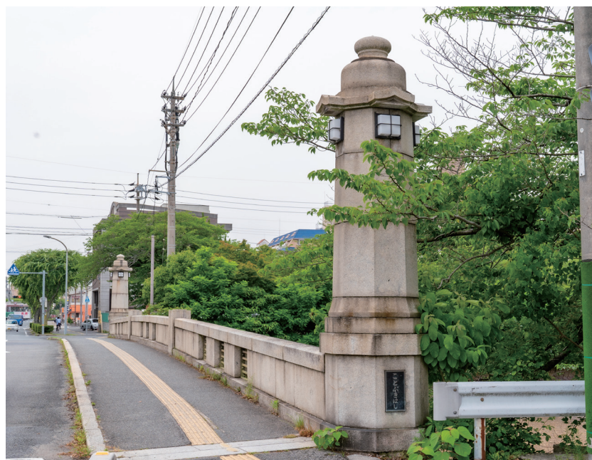
巨大な擬和風の御影石親柱は重厚な造りで、上部には石灯籠のような笠が載り、ガラス窓のような部材が取り付けられている。(L=33m, b=9.4+2m)
