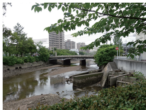
左岸下流にある塩田川ポンプ場
