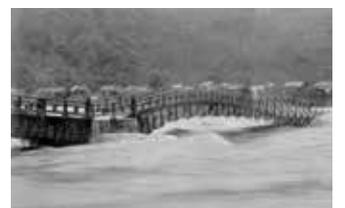
キジヤ台風により流失（S25.9.14）第3、4橋流失し、一方の支脚を失った第2橋が崩壊しようとしている。
