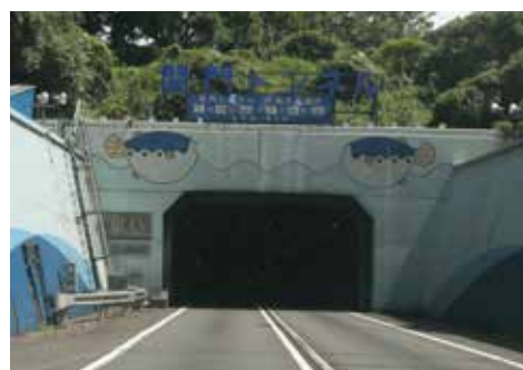
関門国道トンネル（下関側）
