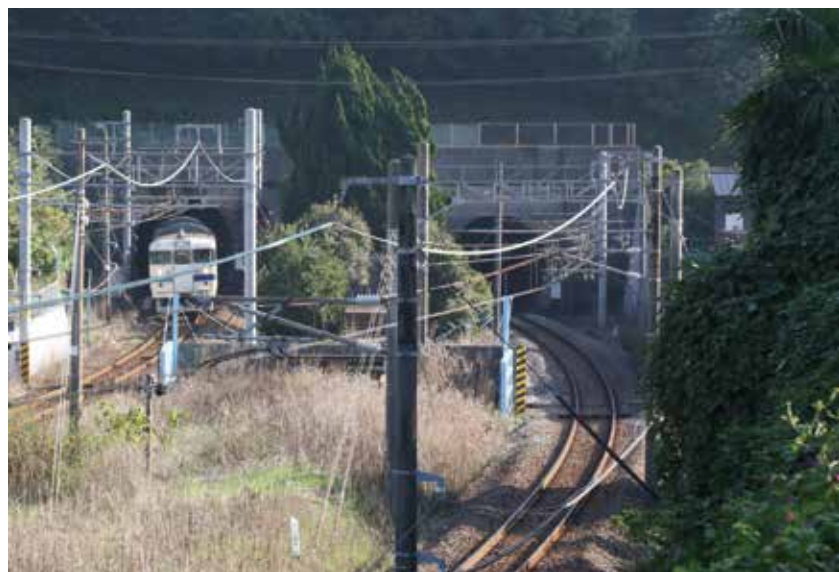
関門鉄道トンネル入り口（下関側） 工事の難易度・工費・万一の脱線事故対策などを考慮し、下りと上り線が別々になっている。
