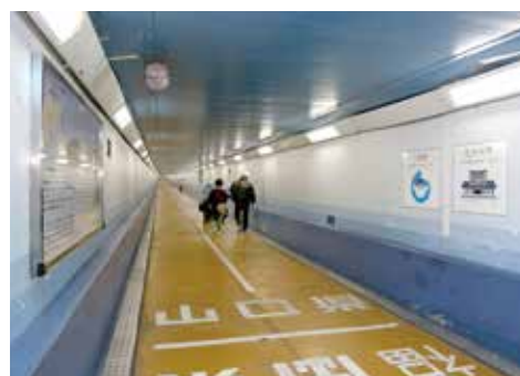
関門国道トンネル人道部 海面下約 58 m の海底トンネル（延長 780 m）は徒歩約 15 分で海峡を渡ることができる。
