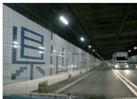
関門国道トンネル内県境部 関門国道トンネル全長 3,925.4m （トンネル部分 3,461.4m）
