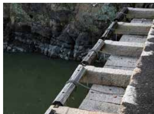
切石による精緻な樋門。地層がむき出しになった側面は、固い岩盤だったことがよく分かる。
