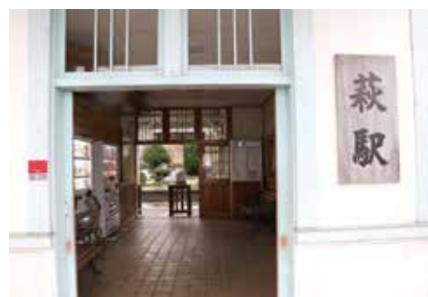
現役の萩駅の改札口 旧萩駅駅舎の向かって左側にある、小スペースの萩駅。
