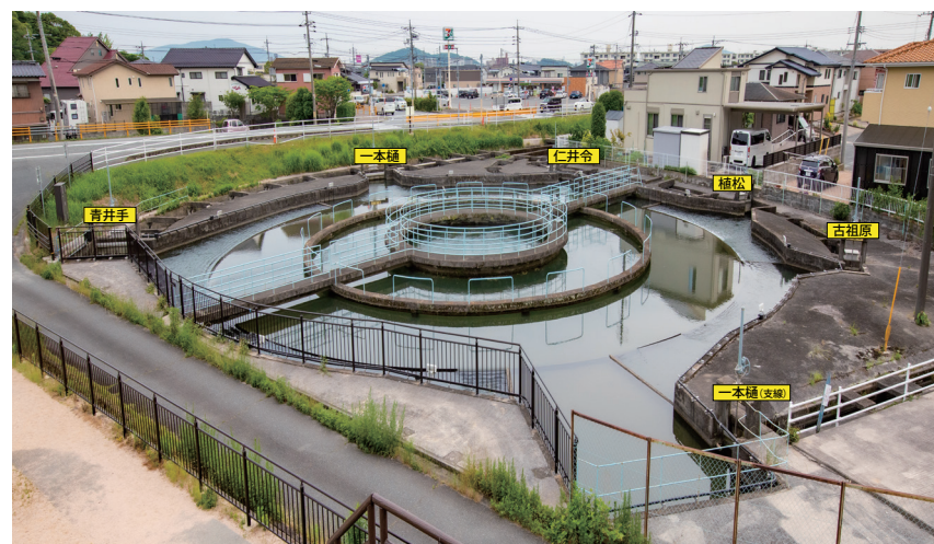
日本一の直径 34 m を誇る防府総合用水の円筒分水工
