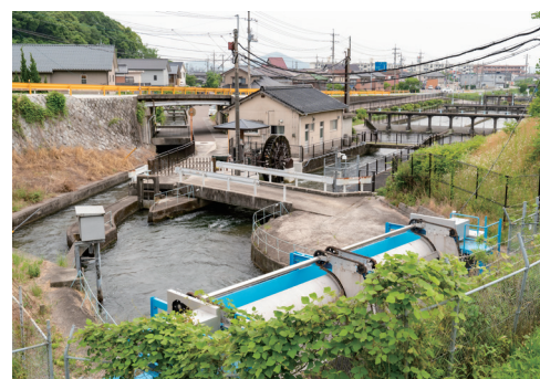
取水口からの水は最初に乙井手（左）が別れ、沈砂池を抜けて円筒分水工に流入する。中央に見える水車は体験学習に利用されている。
