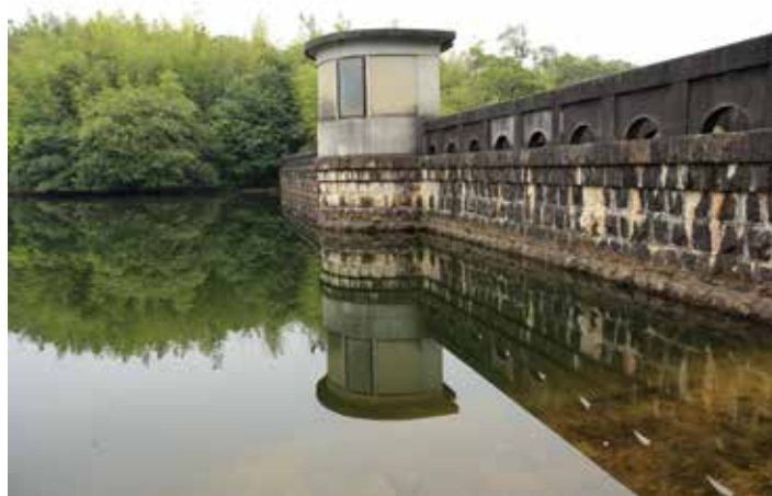
半円形平面の取水塔から底樋を通して下流に供給される
