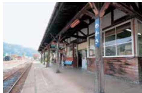
若桜鉄道若桜駅本屋及びプラットホーム 昭和5年に開通した鉄道省若桜線の終着駅。木造平屋建の本屋と、石積プラットホームからなる。当初、本屋は待合室と事務室、休憩室から構成された。
