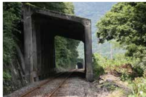
若桜鉄道雪覆 若桜川橋梁から2km西北方に位置し、山からの落雪が線路へ転落するのを防ぐ。延長24m、ラーメン構造。8スパンからなる直線状の鉄筋コンクリート造構造物で、積雪地帯ならではの鉄道構造物。
