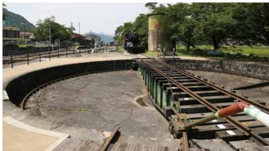
若桜鉄道若桜駅機関車転車台と給水塔 駅構内の下り方北寄りに位置する機関車転向のための転車台。直径15m、プレートガーダーを用いた上路式で、人力によって回転する。ピットには流水を導入して融雪と凍結防止を図っている。給水塔は鉄筋コンクリート造基礎の上に鉄製の円筒タンクが載る構造で若桜駅のシンボリック存在である。
