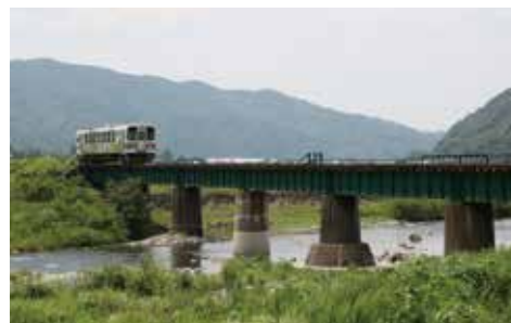
若桜鉄道第一八東川橋梁 若桜鉄道における最長(139m)橋梁で、上路式の鋼製8連桁橋。花崗岩の布積による円形石積橋脚上に、13mの桁3基と19mの桁5基で湾曲させている。
