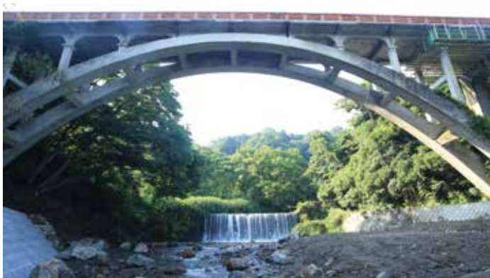
日野川水系の大江川が流れる深い谷間を渡る上路式開腹コンクリートアーチ橋。60 m を超えるスパンを途中に橋脚を設けず一跨ぎ。鉄筋コンクリート造・単連・無ヒンジアーチ橋
