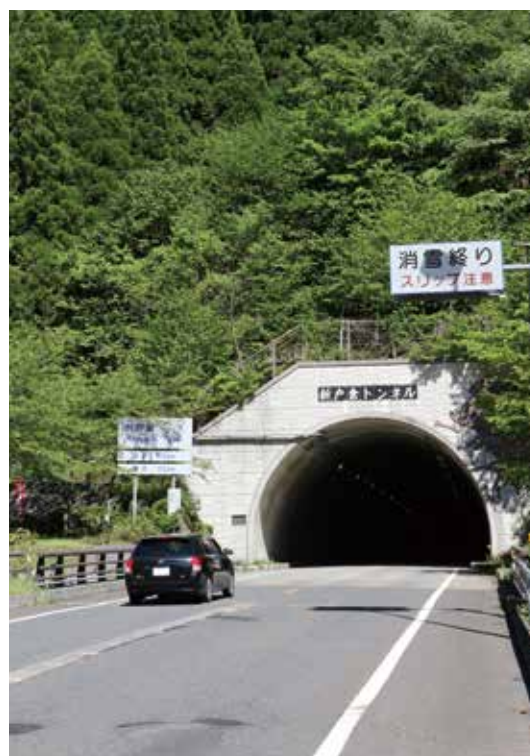
国道29号 新戸倉トンネル（鳥取県八頭郡若桜町落折） 道行く人を守る地蔵（坑口左）はかつて戸倉峠にあったものだという。
