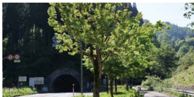
新戸倉トンネル（兵庫県宍粟市波賀町） 新戸倉トンネルに続く現国道29号と並ぶ道が旧国道29号
