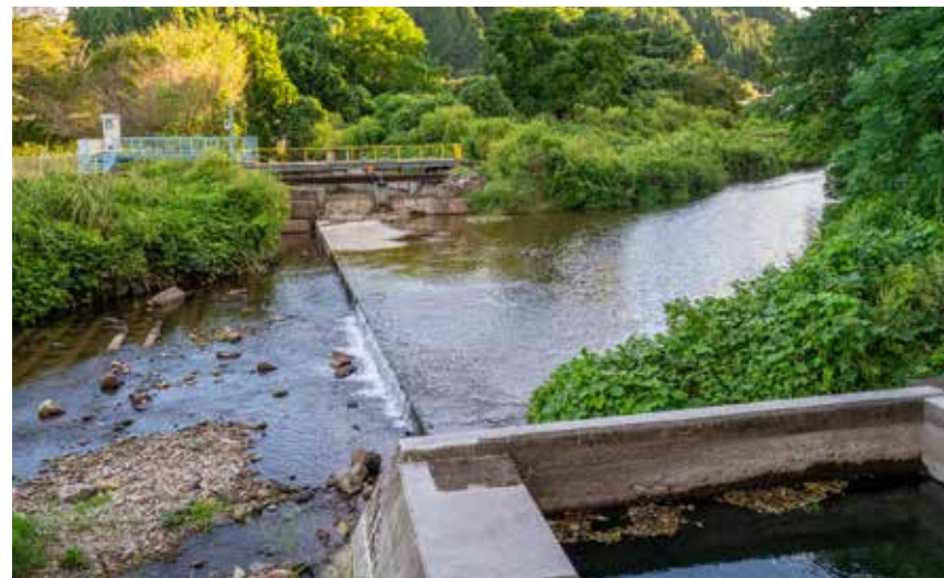
砂見川と大井出川の交差点に設置された砂見川サイホン
