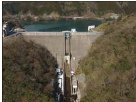
菅沢ダム放流設備 ダム完成 40 年を機に平成 19 年より選択取水設備の設置、小規模放流管の設置が行われた。
