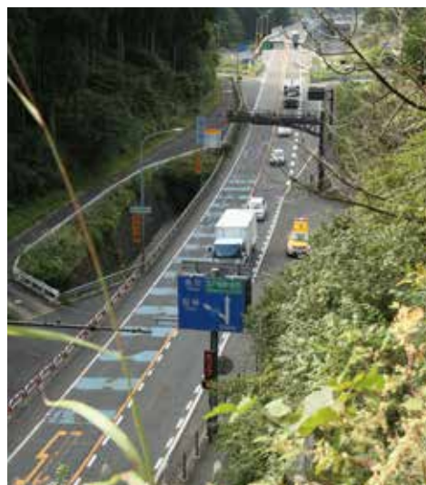
志戸坂トンネル付近から智頭方面へ延びる志戸坂峠道路
