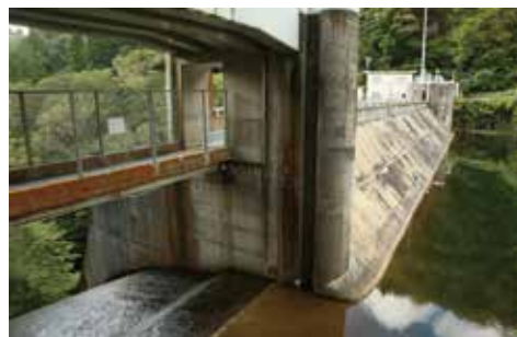
堰堤の左右にあるゲートレスの洪水吐き
