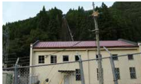
芦津発電所へ送られる水圧鉄管が建物背後に見える。
