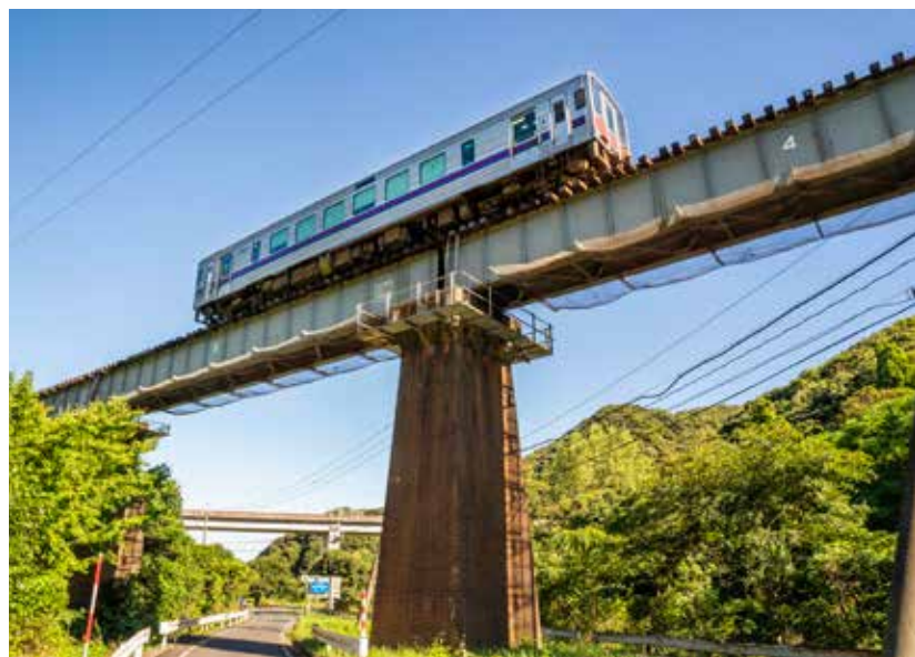
小高い丘の彼方から進んできた山陰本線は、谷間となるこの地点で、陸上川と兩岸の平野部を頭上高く跨ぎ越して走り行く
