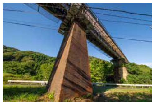
3 本が角型断面の橋脚
