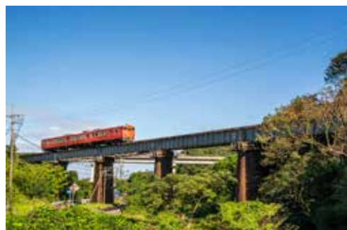
両脇の丘の高さに合わせて高く組まれた橋脚が、総長 140 m のプレートガーダーを支える
