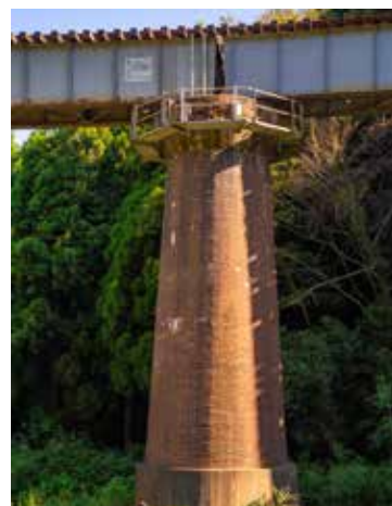
川中に建てられた橋脚 2 本が水流を逃がす効果を配慮して円形断面で仕上げられている
