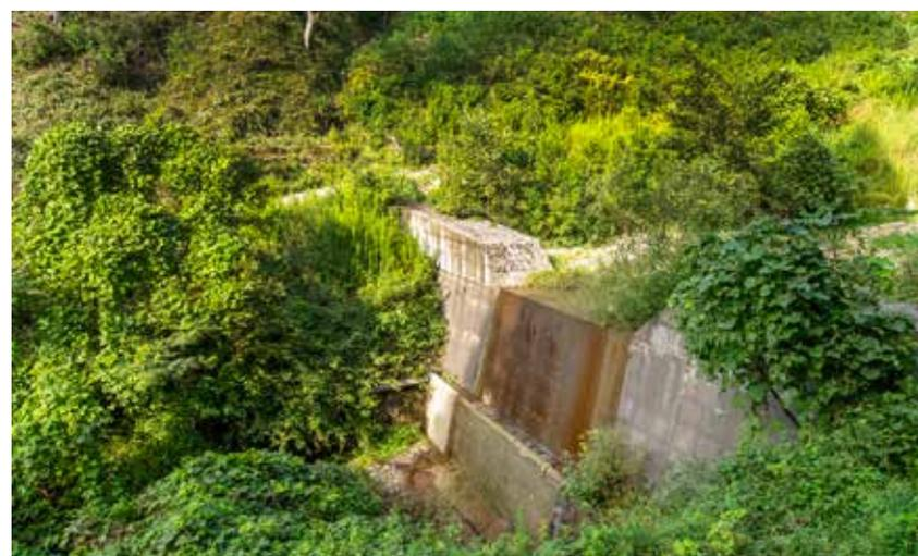
平成 23 年度災害関連緊急治山工事で施工された谷止工（堤長 32.3 m、堤高 7.0 m）
