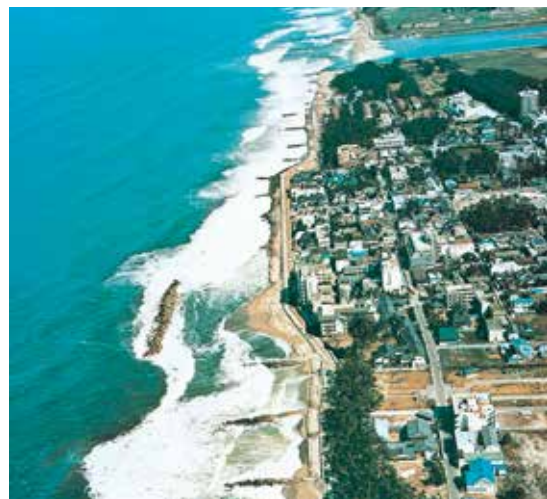
皆生温泉街沖に設置された 1 号離岸堤（昭和 46 年） 1 号離岸堤が設置されると、トンボロ（砂州）が発達しはじめた。
