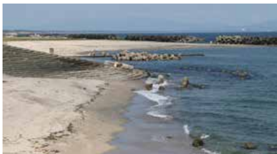
波に洗われる突堤の残骸と、離岸堤でよみがえった砂浜（平成 27 年 2 月）
