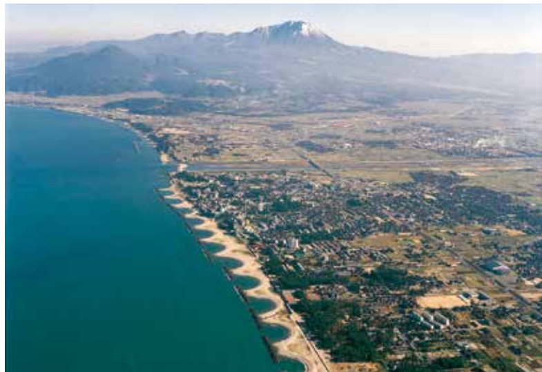
離岸堤により回復した皆生海岸の砂浜（平成 3 年） 離岸堤は皆生温泉街を浸食の危機から救い、砂浜の回復にも目覚ましい効果をあげた。
