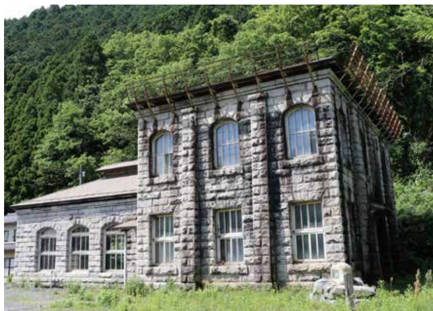
旧江尾発電所本館（江府町） 鳥取県内唯一の石造り建築。屋根についた枠は電線へ滑り落ちる雪を止めるため、壁から突き出した柱が特徴といわれる。
