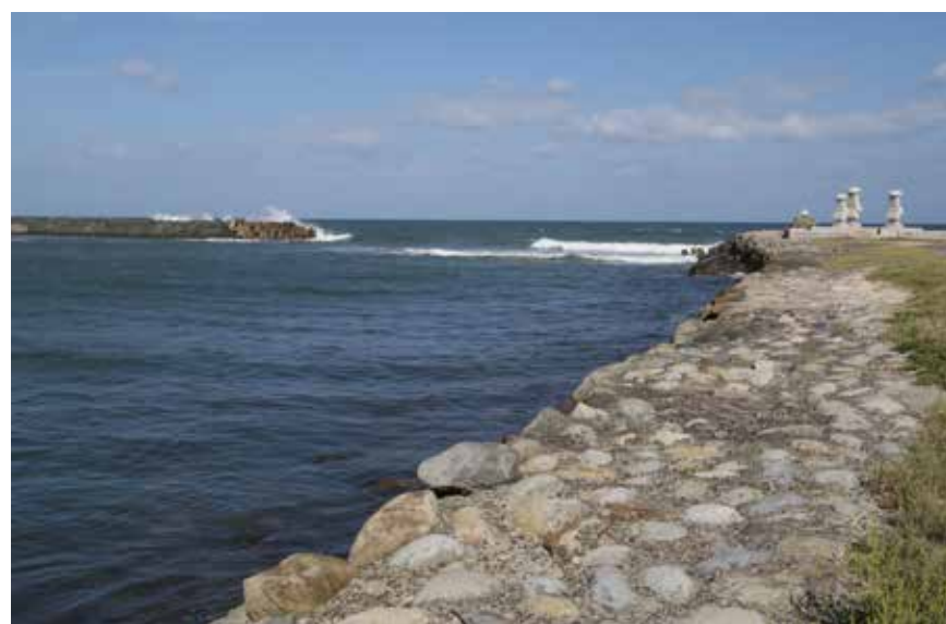
土木学会選奨土木遺産「菊港」西堤（左）と東堤（右） 構造：石造防波堤（玉石積み）、西堤：長さ 157.25 m、幅 5.3 m、東堤：長さ 149 m、幅 13.8 m 東堤にある潮廻しとは、港内の堆積を防ぐため海水の流れを確保するもの。
