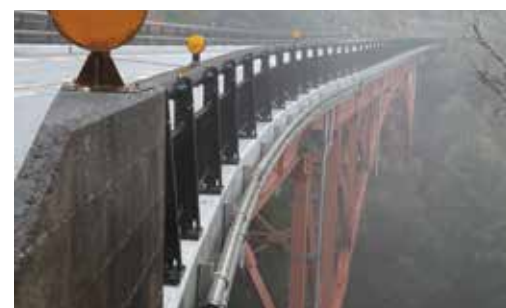
逆ランガーのアーチ橋「西津和野大橋」 全長 118.7 m 幅員 7.5 m
