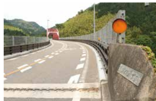
東津和野大橋鈹桁部
