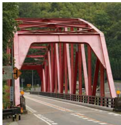
東津和野大橋トラス部
