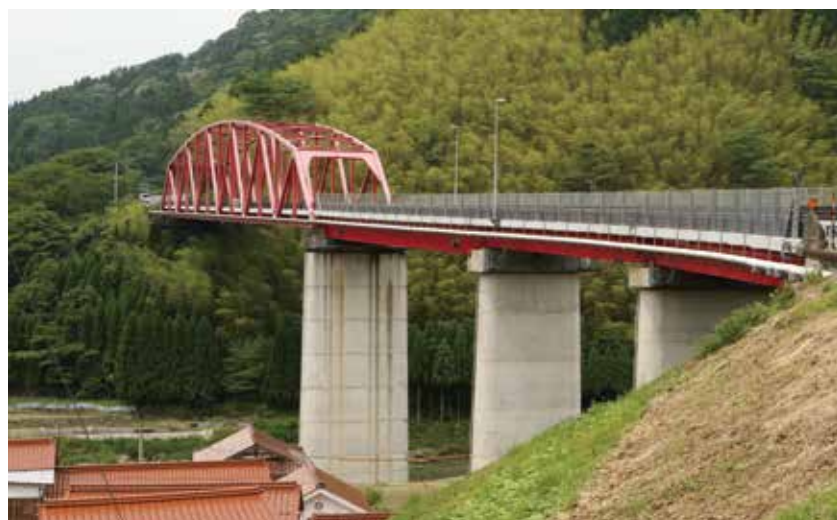
東津和野大橋（下路曲弦ワーレントラス 1 連及び鈹桁） 全長 180 m 幅員 7.0 m
