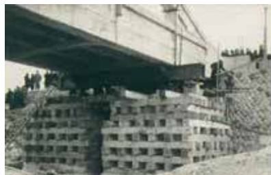
鉄筋コンクリートローゼ桁嵩上げ中（上下写真） 写真提供：大畑熊助氏
