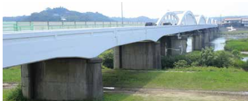
高津川に映る5連のアーチが美しい全国的にも大規模で、かつ島根県では唯一のRCローゼ桁橋。上流側の側道橋は1968年建設。
