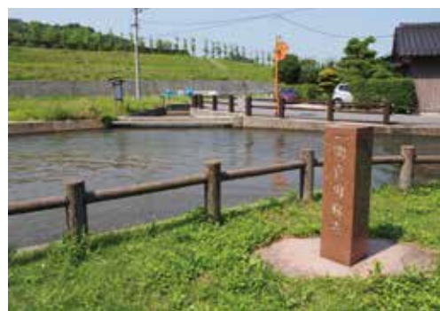
来原岩樋出口の水溜り池 岩樋を通った水は水溜り池に入り、ここから高瀬川(右方向)と間府川(左水門方向)に分かれる。
