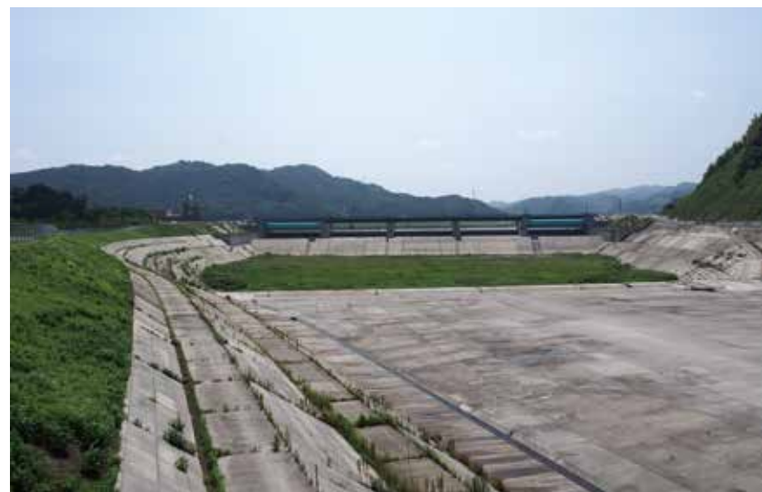
斐伊川神戸川分流水門
