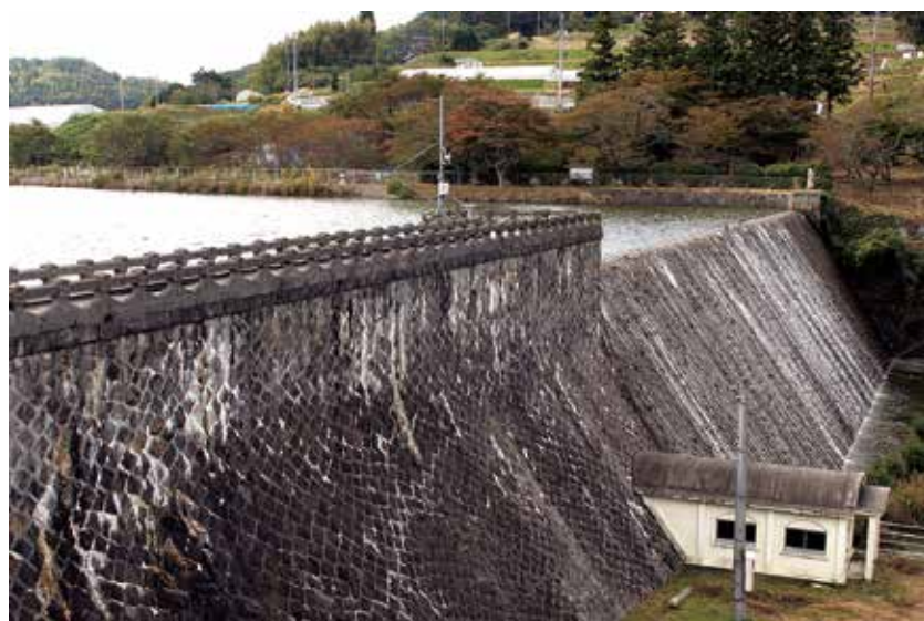
登録有形文化財・土木学会選奨土木遺産「千本堰堤」 堤体内部は粗石コンクリートを用い、表面は間知石の谷積。 堤長 109.1 m / 堤高 15.8 m / 堤体積 7 千 3 m
