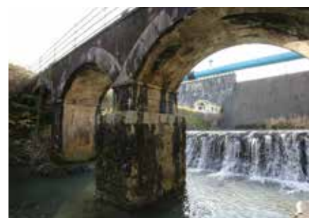
石造りアーチの管理橋
