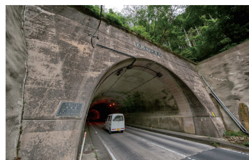
西郷と五箇を結ぶ国道 485 号の五箇トンネル（1984 完成）全長：699m、幅員：6.5m
