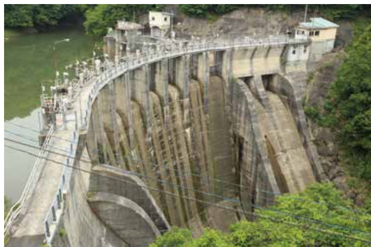
三成ダム 重力式の両翼部や分厚い導流壁は武骨にも見える。左岸側に 2 門、右岸側に 1 門、鋼製ローラーゲートの排砂門が備わる砂防ダム
