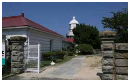
灯台と同じ大型の石材を積み上げた石塀と旧事務所、宿舎
