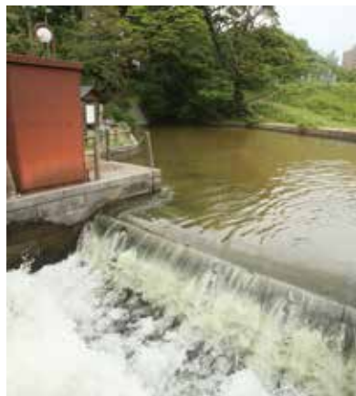
岩樋出口の水溜り池 岩樋を通った水は水溜り池に入り、ここから高瀬川と間府川に分かれる。
