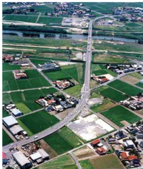
昭和39年完成の旧神戸橋 L=258.0m AW=6.5m (8.0) 単純活荷重合成逆台形箱桁橋
