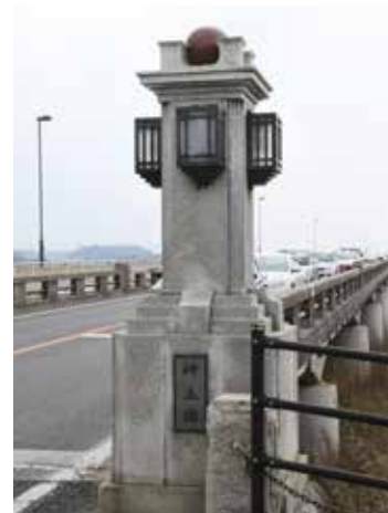
花崗岩に意匠を凝らした親柱 東西の欄干の燈籠とあわせて 10 組が照らす。
