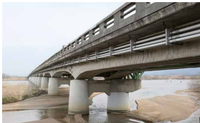
18 径間の鉄筋コンクリート橋「神立橋」 L=417m 有効幅員 7.5 m
