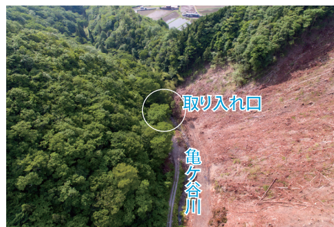
亀ヶ谷川からの取り入れ口
