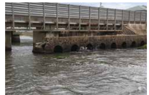
海側から見る掛戸の潮止水門
