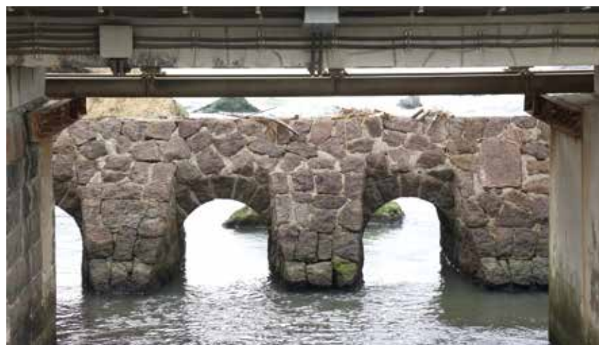
湖側から見る掛戸の潮止水門
