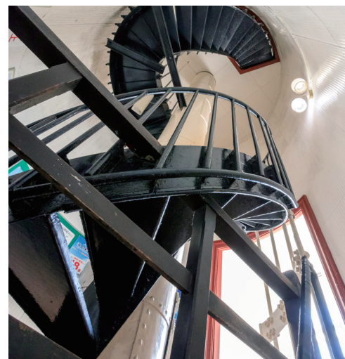
灯塔の外壁は切石積み、内部はレンガを積み立てた二重殻構造。163 段のらせん階段で上部に上がる
