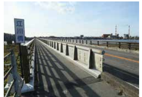
ごうがわぼし 江川橋（1950 完成） 上路式 RC（鉄筋コンクリート）桁 4 径間 + PG（プレートガーダー）桁 12 径間
