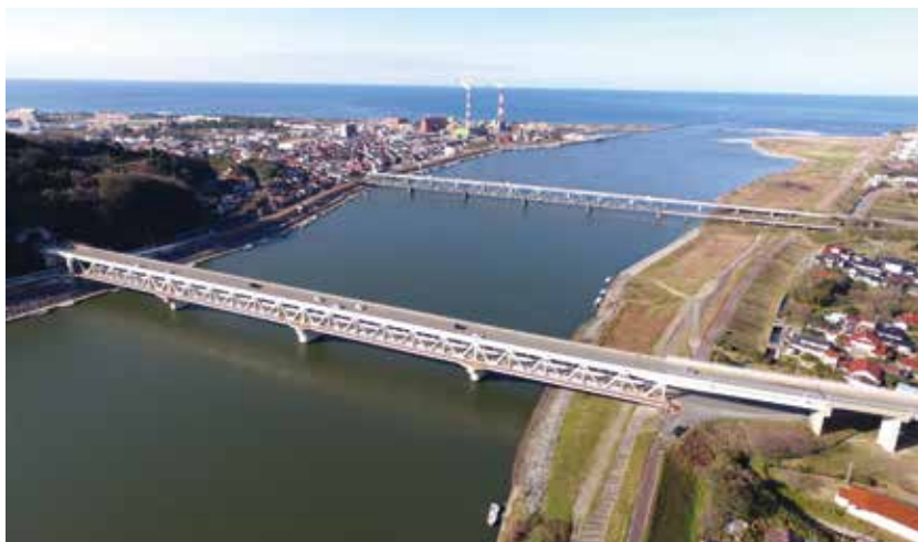
江の川河口に架かる 3 本の橋梁 河口から江川橋、郷川橋梁、新江川橋と並ぶ。
