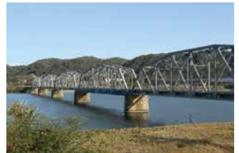
ごうがわ 郷川橋梁（1920 完成） 上路式 7 連 PG + 下路式 5 連曲弦ワーレントラス + 上路式 1 連槽状桁、長さは 488m、幅は 6m
