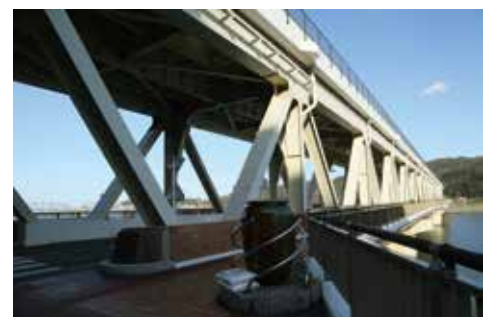
しんごうがわぼし 新江川橋（1993 年完成） 4 径間連続ダブルデッキートラス橋、長さ 378.3 m。橋の名称版は石見焼の「はんど」が、柳宗悦の言葉がそえである。
