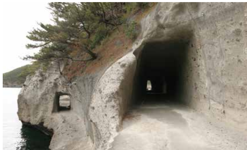
選奨土木遺産「福浦隧道」福浦側から見る
