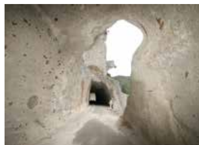
選奨土木遺産「福浦隧道」（上…初代・下2代目） 2枚とも、重栖側から撮ったもの
