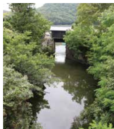
倉安川吉井水門船溜まりの奥が二の水門
