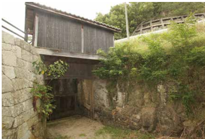
倉安川吉井水門「一の水門」 堅牢に造られた花崗岩の水門
