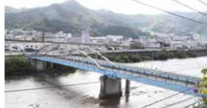
約100メートルの川幅に架けるため、中央のランガーアーチの主桁を張出して吊桁とする事で、56mの桁長を確保している。
